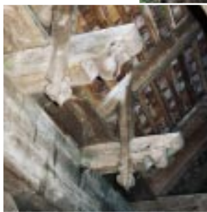
Detail der feinen Zimmererarbeit an der Brücke über die Urnäsch
